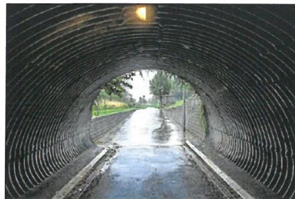
Broen hen over stitunnellen - lige ved siden af broen over Svinninge Å - skal også renoveres.
