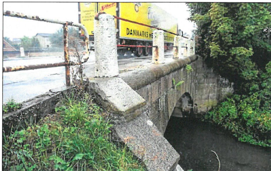
Renoveringen af broen på Hovedgaden i Svinninge går i gang i næste uge.
