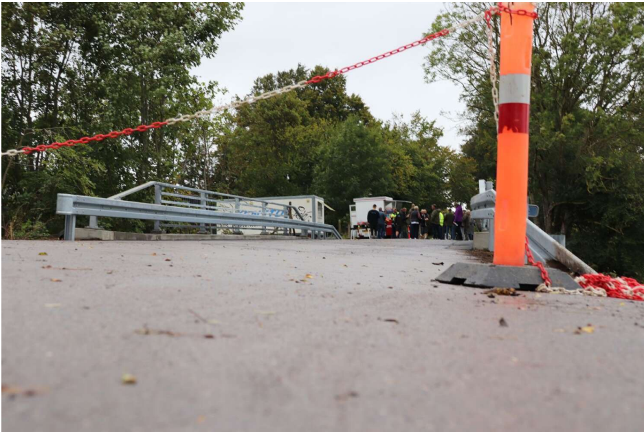
Den gamle bro over åen er blevet erstattet af en ny bro, der er bygget op med elementer funderet på betonbjælker og pæle. Foto: Martin Rasmussen
